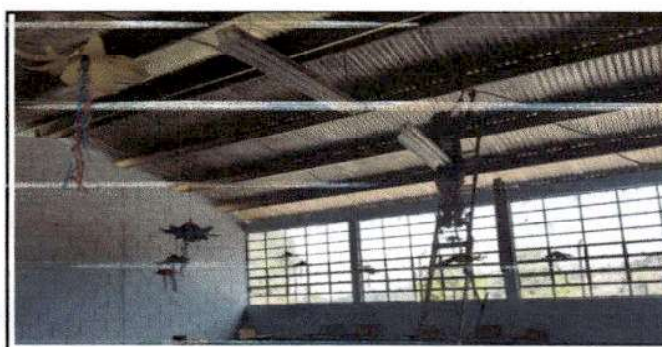
Foto 6: Realización de instalación de unidades de luz ( incluye interruptor, plafoneras, lámparas, focos, cable, tomacorrientes).
