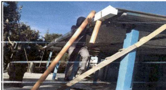
Foto 4: Realización de sustitución de canal de pvc.
