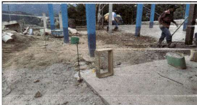
Foto 3: Realización de reparación de piso de torta de concreto.
