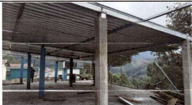
Foto 1: Realización de sustitución de lámina, por lámina troquelada aluzinc ibre 26
