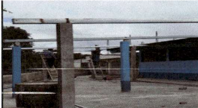
Foto 2: Realización de sustitución de estructura de soporte de madera, por metal.
